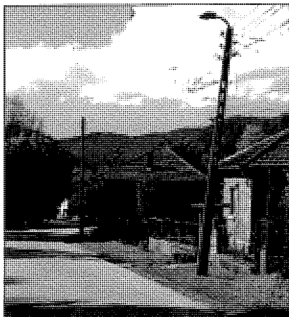
Фигура 7. Изкривен железобетонен правоъгълен стълб
